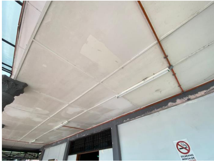
Keadaan semasa luar dewan
